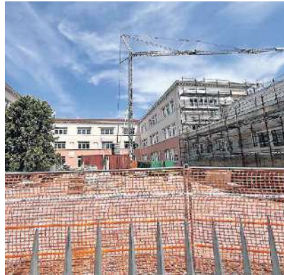
LICEO rinnovato, sono in fase di conclusione i lavori al Tiziano
